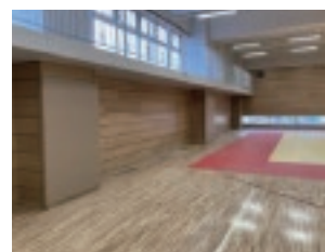
学校施設 公共施設 壁面防護マット
